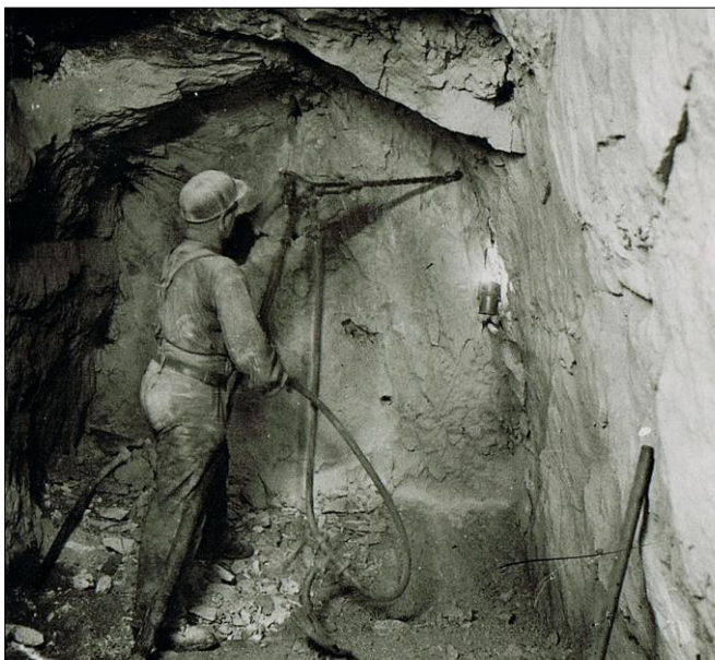
Ein Bergmann der Grube Holzappel beim Bohren mit Druckluft für den Streckenvortrieb
