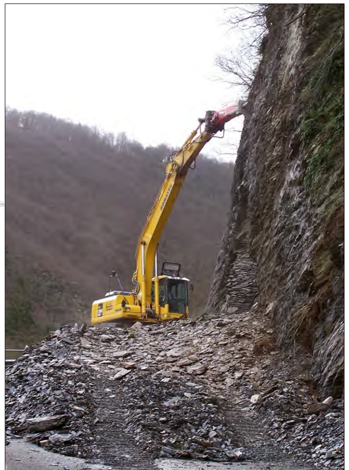
Diesen Spezialbagger fotografierte beim Abspitzen einer Felsnase Klaus Maxeiner am 21. Januar 2005
