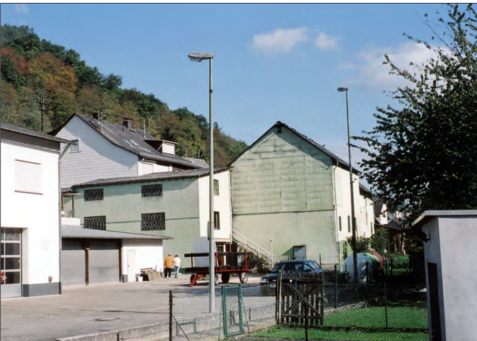
Das Gesamt-Anwesen 2007 aufgenommen vom unteren Platz des Dorfgemeinschaftshauses
