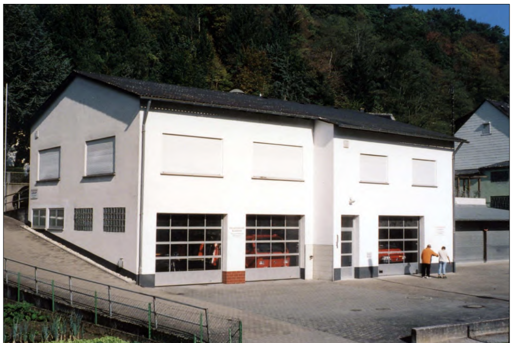
Das Dorfgemeinschaftshaus von der Südseite. Edgar Kah erzählte mir, dass der Anbau 1990 für Feuerwehrerefordernisse um 1,30 m vorgezogen werden musste.
