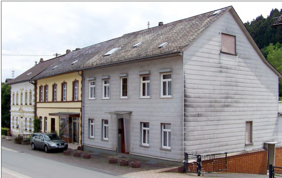
Dieses Foto von 2006 zeigt von rechts die Häuser Hauptstr. 26. 28. und 30
